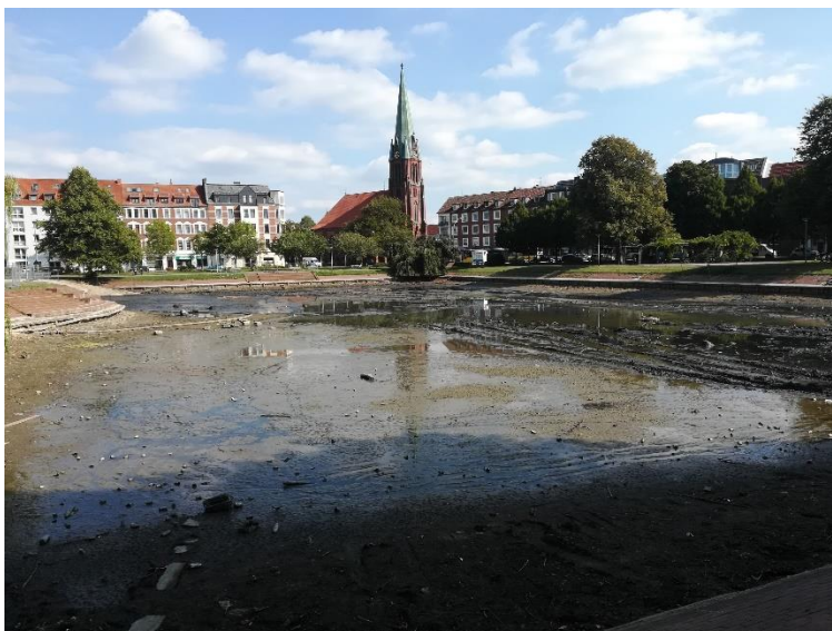
Während der Umbauphase
